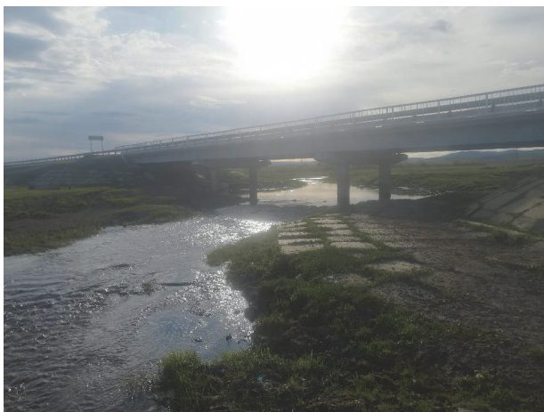
Рис. 1. Исследуемый мостовой переход через р. Санга Южная (вид вниз по течению)
